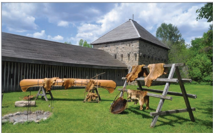
Az 1647-ben épített délnyugati kőbástya
